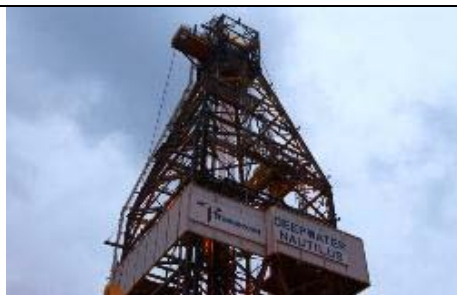
Rig tower DSC_0486.jpg
