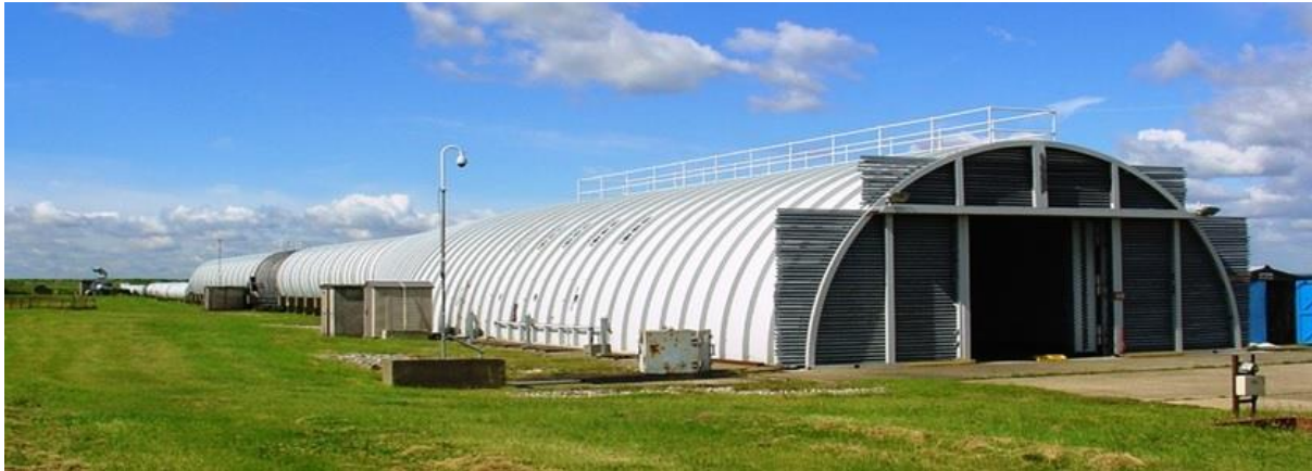
Figure 1. The Air Blast Tunnel (ABT)
