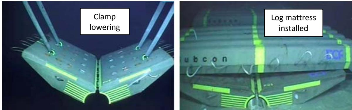
**Figure 1. Pipe-clamping mattress (Frankenmolen et al, 2017)**
